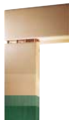
Eckverbindung mit acht Dübeln und unsichtbarer Verleimung
